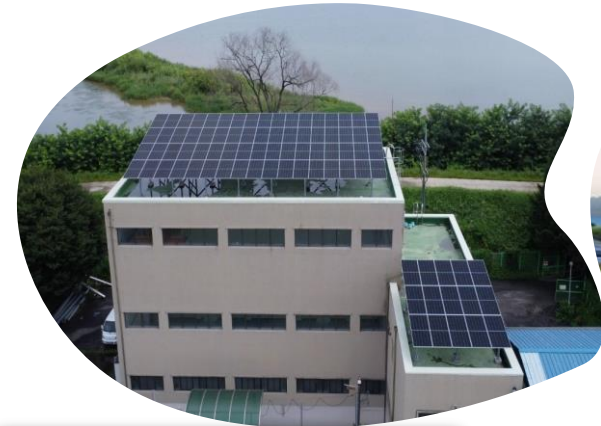
▼ 배수펌프장 옥상 시설 전경
